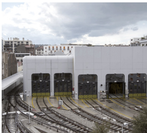
Atelier de maintenance des trains de la ligne 9
