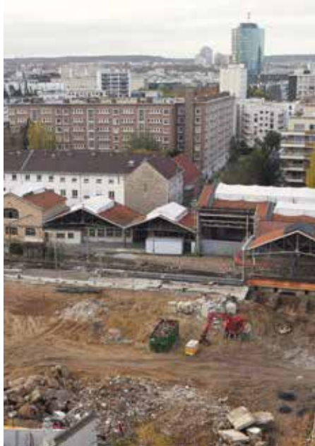
Façade du bâtiment de logements privés du côté de la voie nouvelle reliant la rue Théodore Deck à l'impasse Villa Lecourbe. Conception architecturale agence Hamonic & Masson (image non contractuelle).
